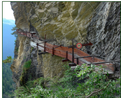
Die luftige Konstruktion näher betrachtet
